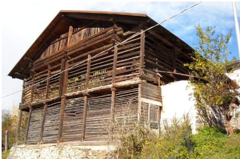
sui lati esposti alle intemperie dominanti ma anche un ripensamento sulla loro funzione che si riduce sempre più fino a scomparire del tutto. Sorgono così nuovi tipi edilizi: stalle-fienili completamente in legno, riproponendo l'originario assetto strutturale interno ma chiuse su ogni lato da mantellate di tavole; altre in muratura non solo per la stalla ma parzialmente anche per il fienile, con diedri angolari a sostegno del corpo di copertura.
