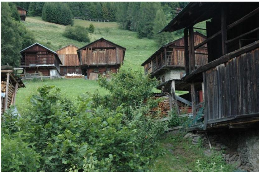
dell'incavo di ammorsamento agli angoli. La tipologia costruttiva sarà definita a castello anche se in determinati setti un certo numero di travi sono interrotti da elementi verticali, soluzione usata per connettere pareti più lunghe dei tronchi a disposizione e per realizzare gli stipiti di vani porta.
