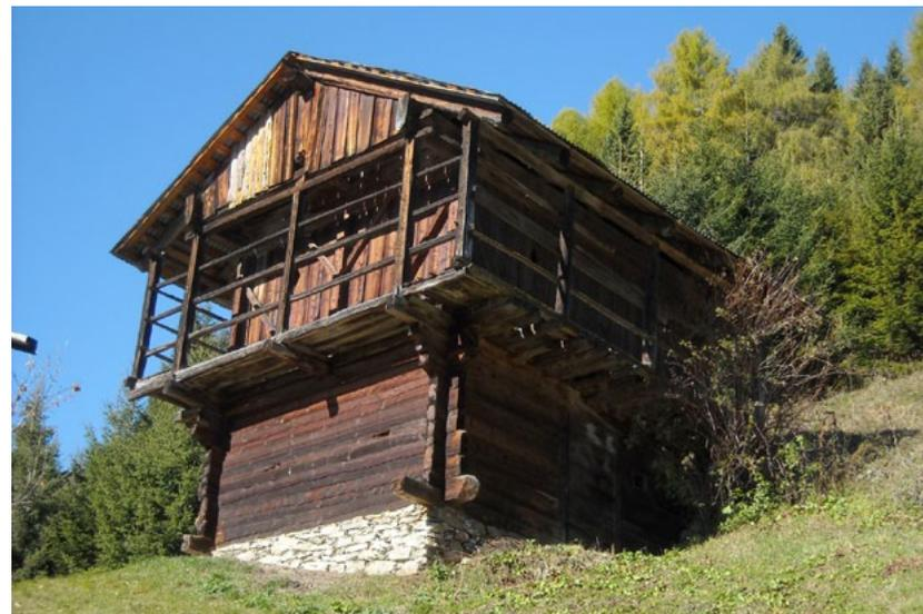
del terreno le componenti lignee. Le parti murate a monte generalmente si prolungano con muri di sostegno esterni per migliorare il raccordo in piano del primo livello di utilizzo all'andamento del terreno circostante.
