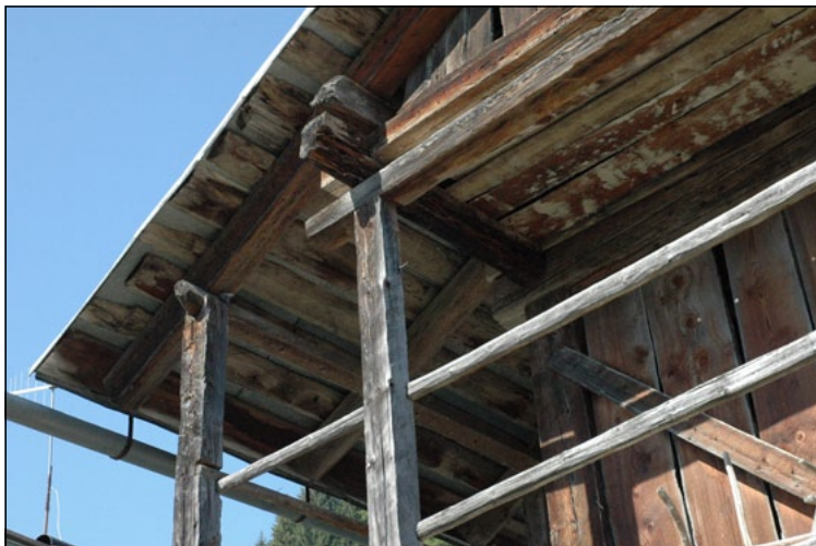
Mensole della cordolatura laterale a sbalzo sul ballatoio a valle. Sporto dei correnti su cui è ancorata la trave di bloccaggio dei ritti reggi stanghe del ballatoio.
