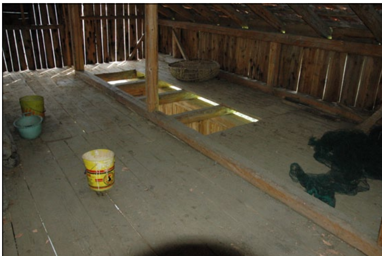
Trave ripartitrice sotto le colonne dei telai di copertura a sostegno delle terzere e del colmo.
