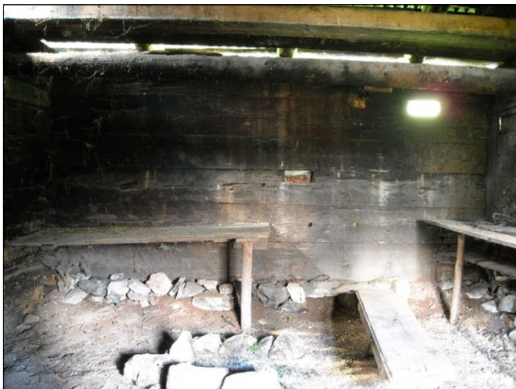
Angolo posteriore a valle con perfetta connessione/giacitura delle travi di incastellatura nonostante la rotazione complessiva subita dall'edificio.
