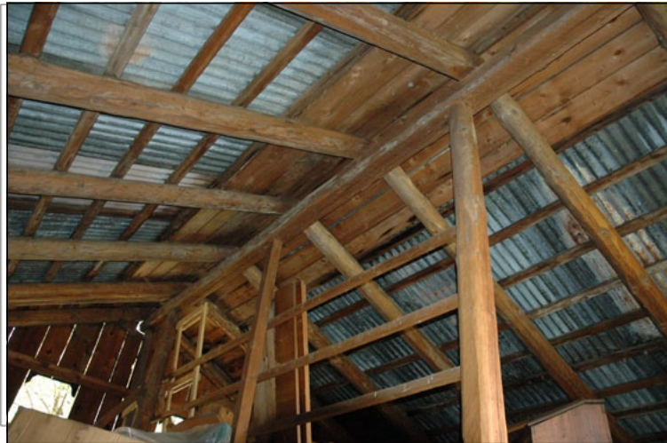
Le colonne reggi colmo consentono l'installazione di listoni per realizzare setti utili alla separazione del foraggio di diversa qualità.
