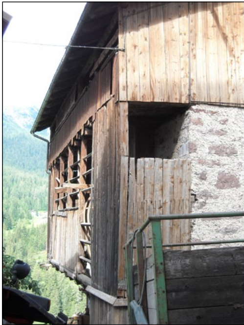
Il ballatoio con stanghe per l'essiccazione era previsto solo sul lato meno esposto alle intemperie dominanti. I rimanenti lati, compreso quello a valle usualmente aperto, sono racchiusi in mantellate di tavole ancorché sufficientemente distanziate per favorire l'aerazione.
