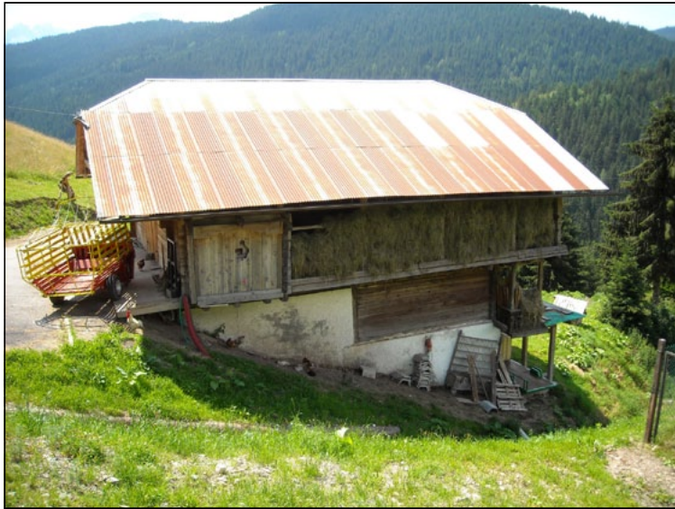
Vista laterale esterna.
