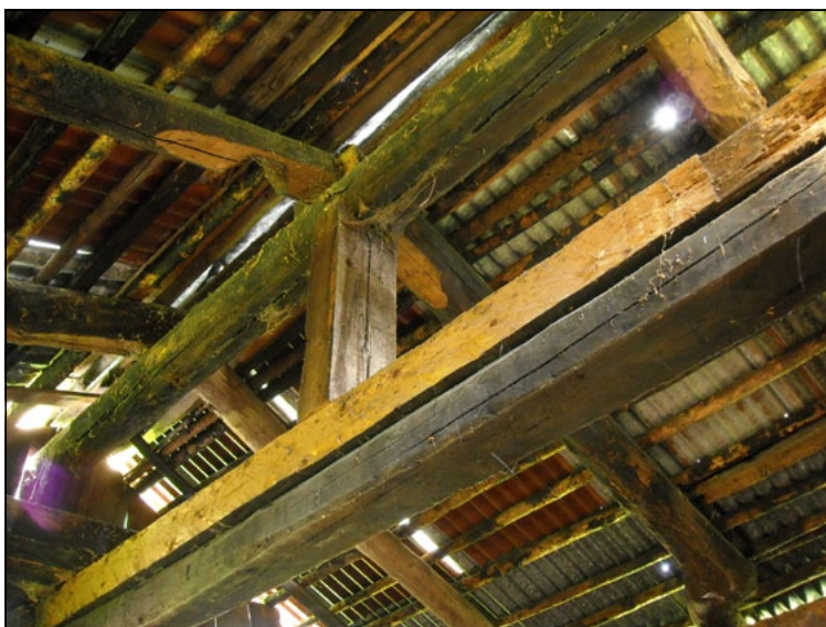
I travi correnti di copertura sono stati riposizionati e riadattati con i lavori di parziale ripristino dopo il crollo.
