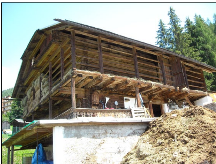
Vista dal primo livello, quota della concimaia e pertinenze.
