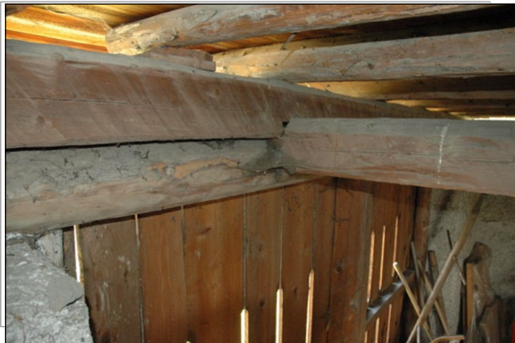
Innesto della trave rompitratta interna sulla cordatura perimetrale. Differenze nella sezione delle travi di solaio risolte con zeppe.
