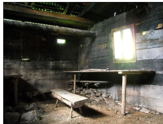
Parete divisoria che separava gli ambienti di conservazione del latte e del formaggio.
