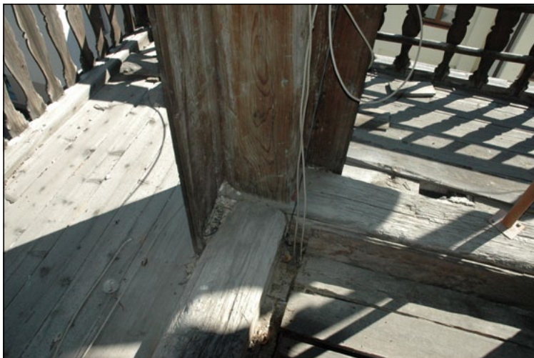
Colonna d'angolo e connessione con la cordolatura di base. All'esterno angolo della balconata con l'incontro delle balaustre con tavolette sagomate a colonnetta.
