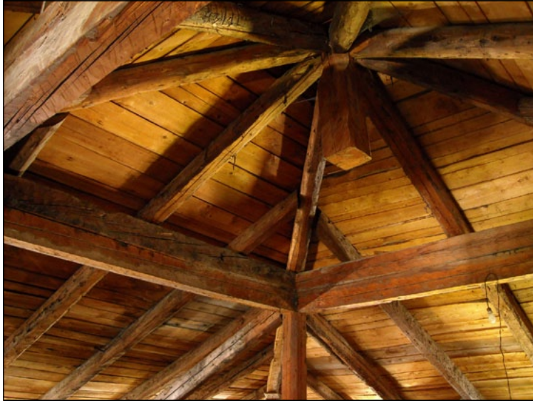
Incontro sul monaco dei correnti di dislivello e di quelli mediani.
