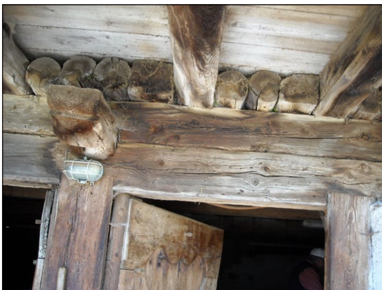
Cordolatura sotto solaio sul punto dove funge da piattabanda per le porte delle stalle. Le travi del solaio formano il piancito; ogni tre/quattro una esce in funzione di mensola reggi ballatoio.
