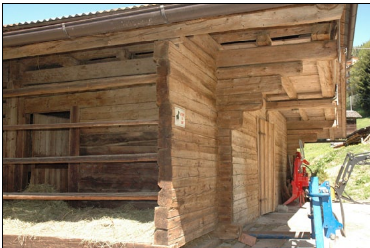
Vista del fronte a monte.
