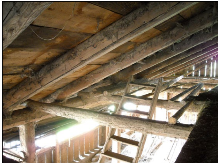
I correnti di copertura ancorati alla trave di colmo poggiano sulla trave di bordo e quella di gronda.
