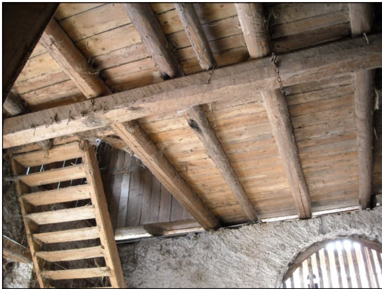
Sulla trave rompitratta si attestano i montanti della scala.
