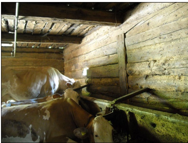
Pareti d'ambito e solaio della stalla al 2° livello.
