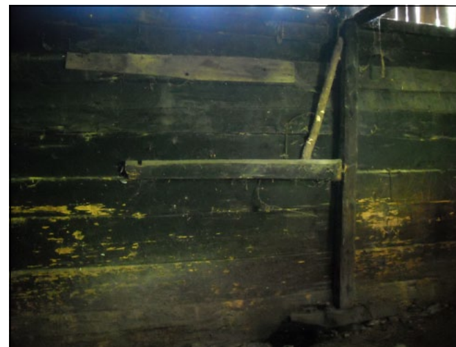
La "mùssä", braccio mobile per appendere il pentolone del latte da scaldare (privo del puntone reggi leva ora precariamente bloccato con tirante).
