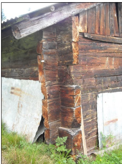
Sull'angolo esterno a valle le travi sporgenti dopo l'incastro sono state regolarizzate.
