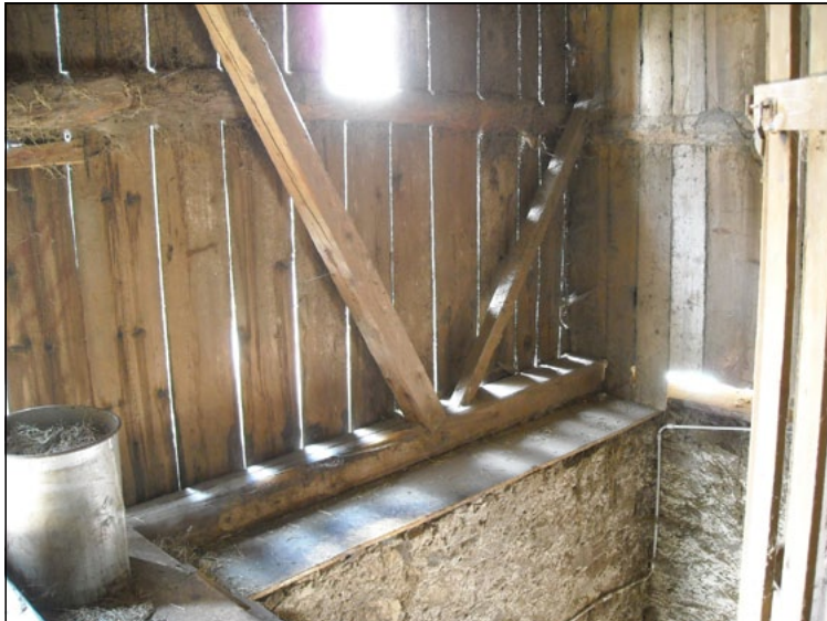
Il telaio controventato al 3° livello sull'angolo della scala.
