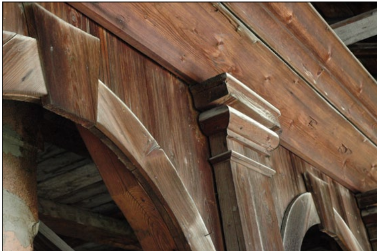
Assemblaggio di legni e tavole sagomate per la formazione del loggiato su modanature classicheggianti.
