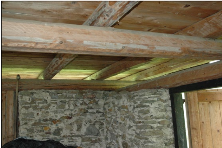
Tra l'impalcato del secondo solaio ed il pavimento sovrastante si forma un'asola di aerazione su tutto il perimetro del fienile.
