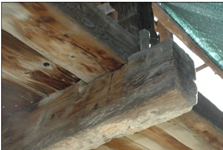
Estremità della mensola a sostegno del ballatoio con cavicchio di bloccaggio della trave ripartitrice di bordo.
