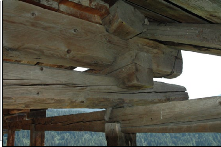
Nodo della cordolatura superiore sul filo esterno del ballatoio a valle. I ritti del ballatoio sono ancorati sulla trave all'intradosso del soppalco a valle bloccati da spinotti infissi nelle travi di cordolo.
