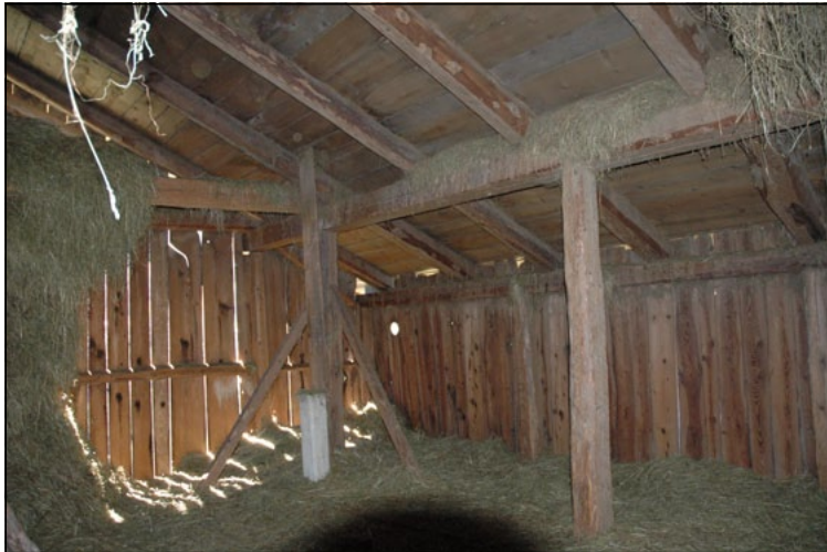
Trave di bordo con colonne sulla linea della muratura.
