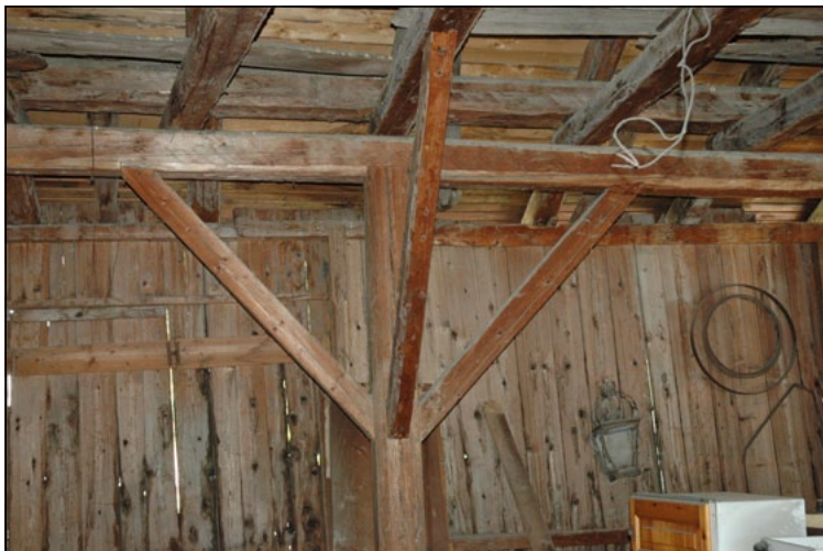
Le colonne sono sempre controventate da saette disposte su piani tra loro ortogonali. Sulla mantellata, nel lato a monte, è ricavata l'apertura per l'accesso con carro dalla rampa/ponte ora rimossa.
