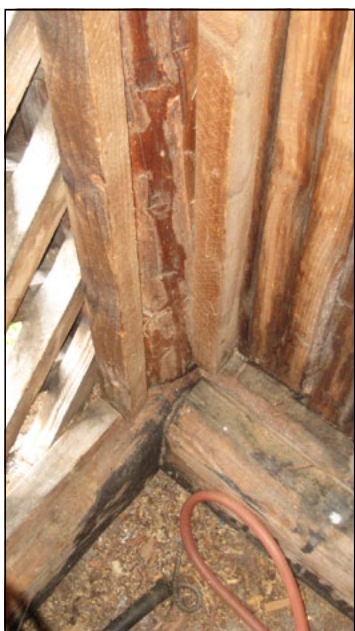
Colonna d'angolo ammorsata al cordolo di base ed all'impalcato del secondo solaio. In evidenza i controlistelli di bloccaggio della mantelata di tavole e del grigliato.
