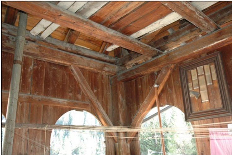
Colonna d'angolo con controventatura sulla cordolatura perimetrale. Mantellata esterna con aperture sagomate ad arco.
