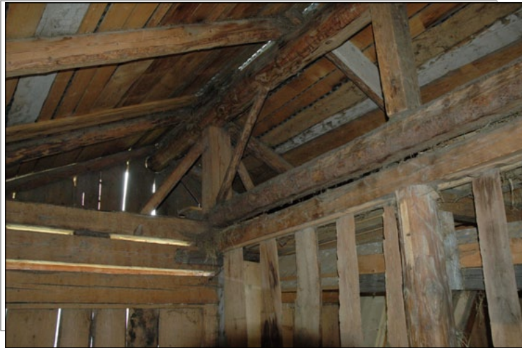
Controventature sul monaco e sul sottocolmo per irrigidire la trave di colmo. La cordolatura all'imposta della copertura è realizzata con una coppia di travi a sezione maggiorata.
