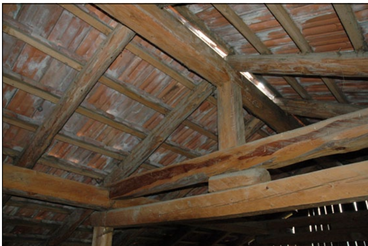
Colmo e terzere sostenuti da catene con doppie travi.
