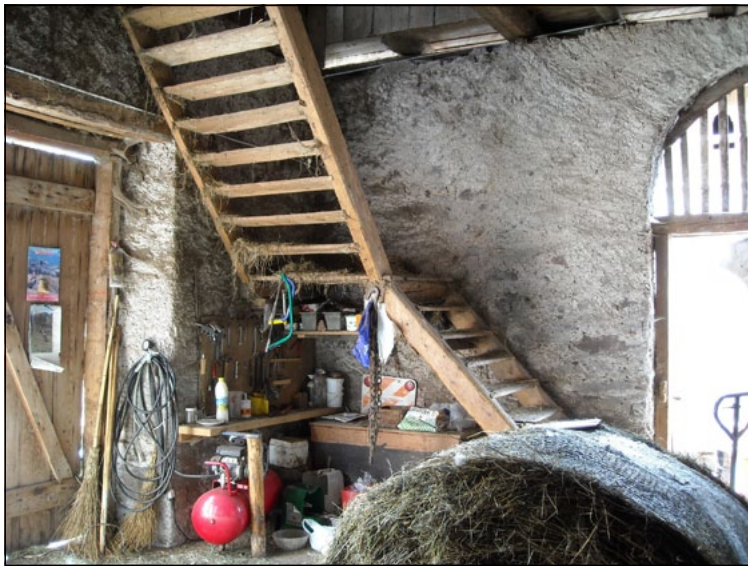
Scala di collegamento tra il 2° ed il 3° livello d'uso.
