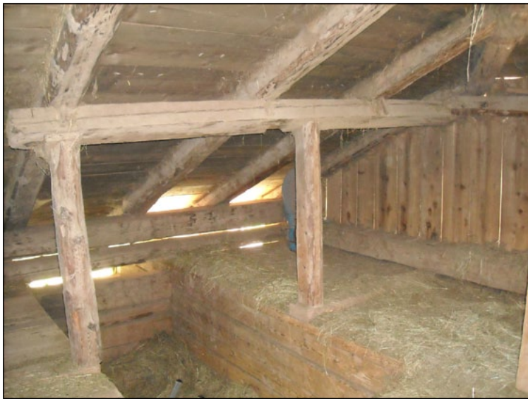
All'estremità, su entrambi i timpani, parziale terza sorretta da colonnette per il sostegno dei correnti principali di falda che non arrivano alla trave di colmo ma si concludono sui correnti di displuvio.
