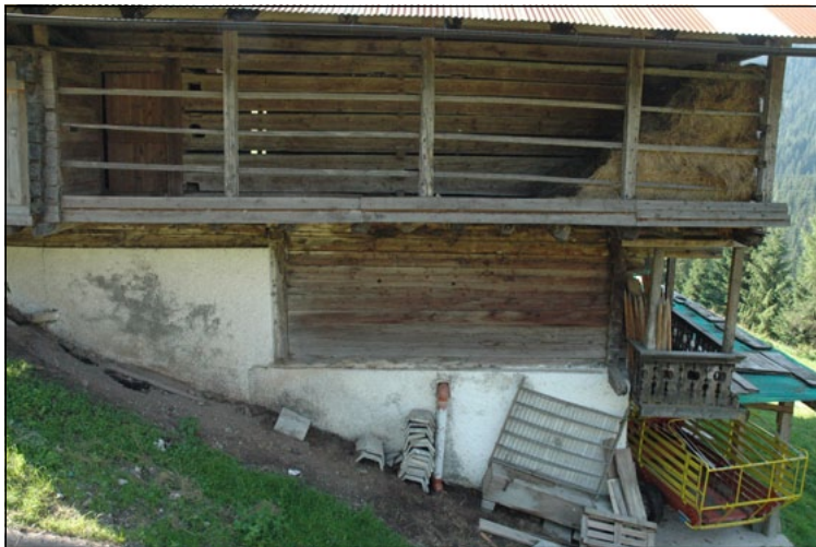
I piani d'uso sono raccordati al pendio con setti in muratura.
