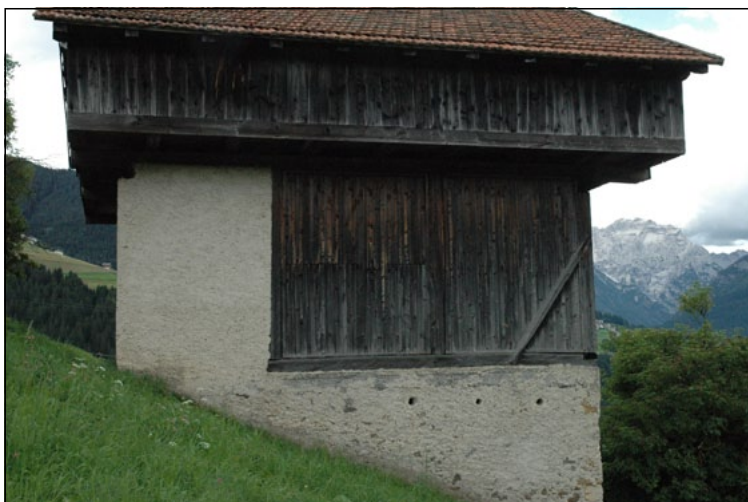
Il lato esposto alle intemperie dominanti rinuncia al grigliato di aerazione e presenta la mantellata di tavole completamente chiusa.
