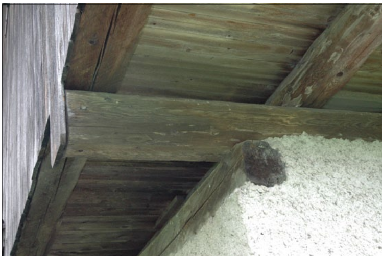
In corrispondenza della trave mensola dalla mantellata una tavola si allunga per la protezione della testa.
