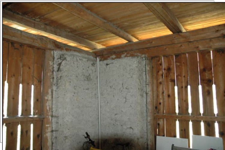
Cordolatura in appoggio ai diedri murati con la coppia di travi sul lato lungo ammorsate alla trave singola sul lato corto.
