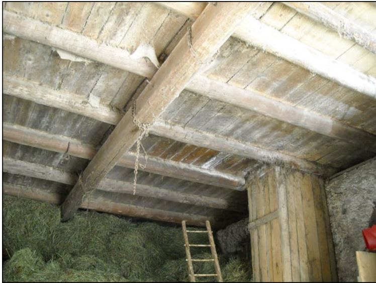
Trave rompitratta mediana e canale per l'immissione del fieno nella stalla.
