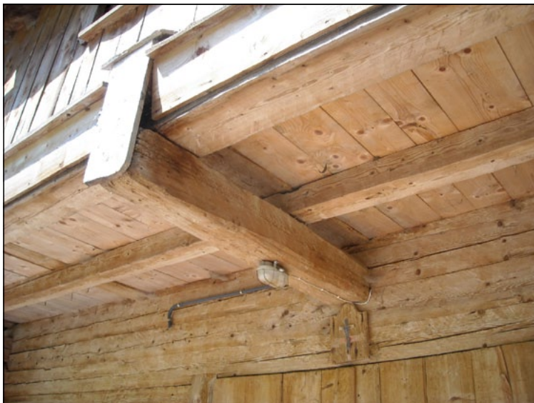
Trave rompitratta mediana in uscita a mensola sull'aggetto sopra il portone del fienile. Tavolette di sacrificio a protezione delle teste.
