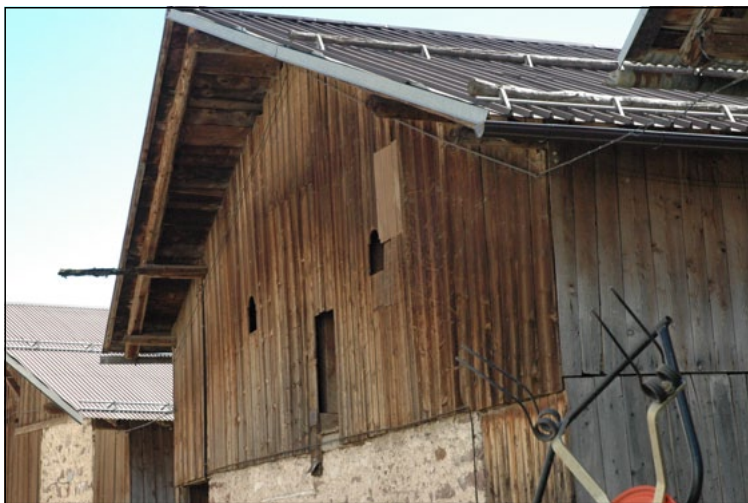
Il volume di sottotetto realizzato con telaio controventato è completamente chiuso da mantellate di tavole.
