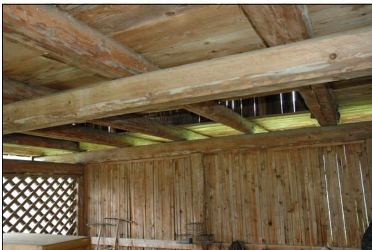
Grossa trave mediana rompitratta per il solaio del 3° livello. Le travi del solaio poggiano sulla cordolatura determinando un'asola che concorre all'aerazione del fienile.
